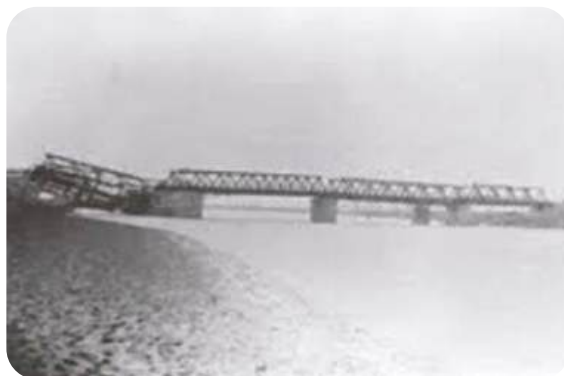
Hình 2.17. Cầu Lai Vu bị bom Mỹ phá sập lần thứ hai (ngày 16 – 10 – 1972) (Nguồn: Bảo tàng tỉnh Hải Dương)
