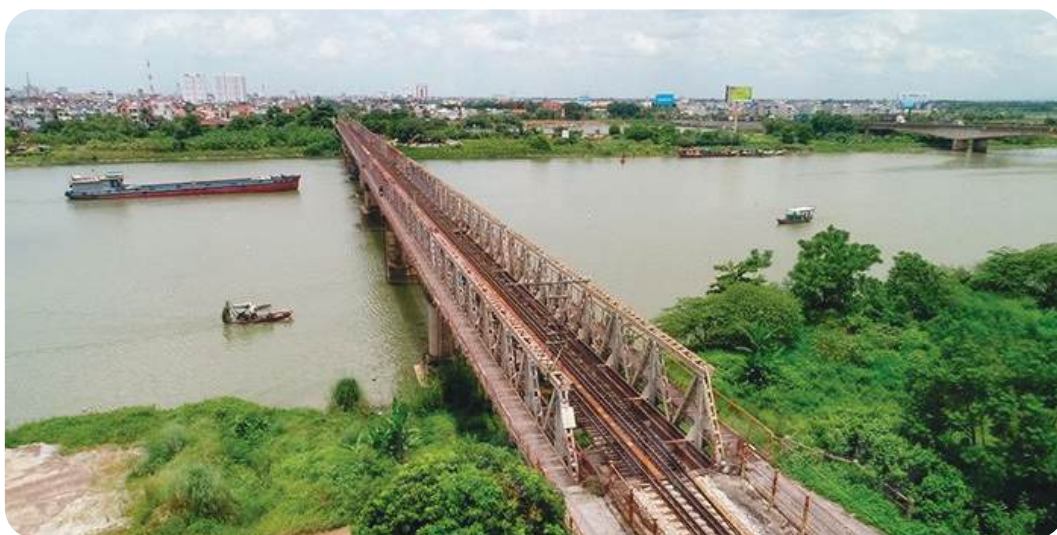
Hình 1.1. Cầu Phú Lương trên đường 5 cũ tại thành phố Hải Dương
