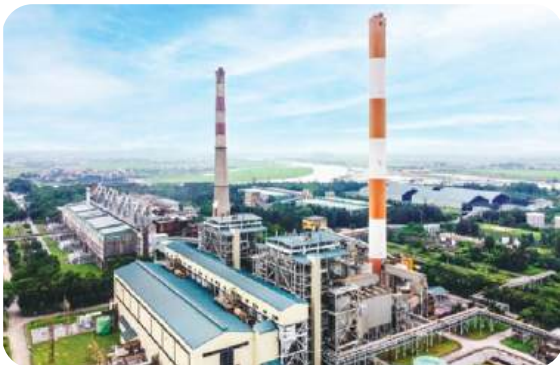
Hình 3.4. Nhà máy nhiệt điện Phả Lại hoạt động từ năm 1979
